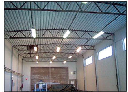
Hallin kattoon ruiskutettu SpreFix G hoiti samalla lämpö ja kondenssieristyksen. Myös hallin jälkikaiunta-aikaa saatiin pudotettua merkittävästi.
